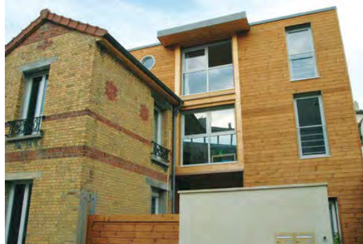
Extension d'une maison à Issy-les-Moulineaux (92) volumétrie compacte, toiture terrasse. photo Laferriere archi
