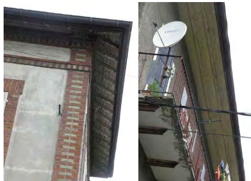
Passées de toit caissonnées traditionnelles Passée de toit avec chevrons apparents,
