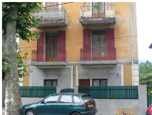
Interdit : le retrécissement des ouvertures au rez-de-chaussée. Av Marlioz
