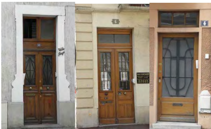
Portes en bois vitrées avec ferronnerie
