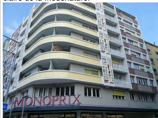
Grenoble, grands boulevards. Un travail de coloration d'ensemble a permis de dynamiser ces alignements monotones.
