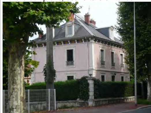
Toiture à 4 pans, couverture en ardoises
