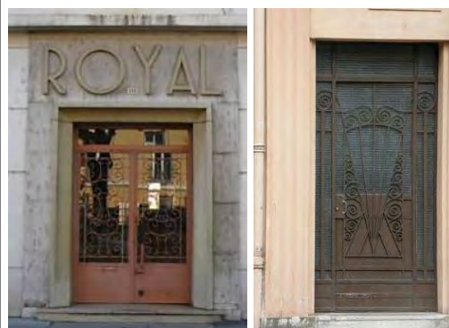
Portes vitrées en ferronnerie
