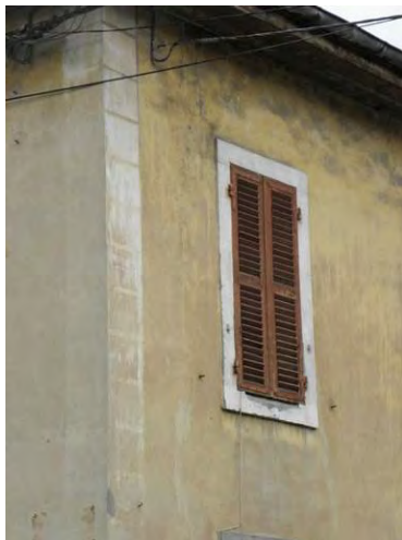
Exemple de décor peint sur enduit lissé à conserver
