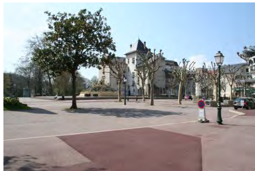
Limiter les traitements d'espaces publics en enrobé et les reprises « techniques »
