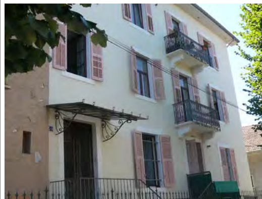
Bel ensemble de volets battants persiennés, à conserver. Av Tresserve
