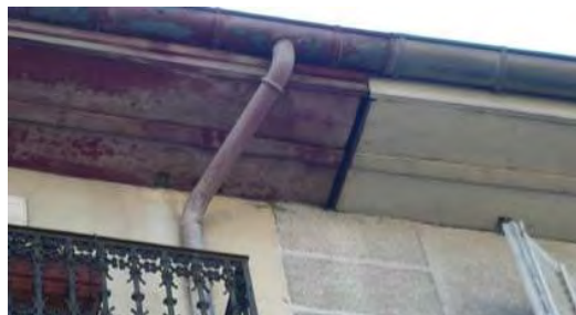
Passées de toit caissonnées traditionnelles
