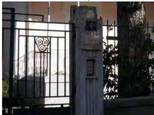
Grilles en serrurerie sur mur bahut
