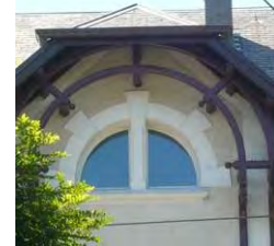
Ouverture cintrée Pose correcte
