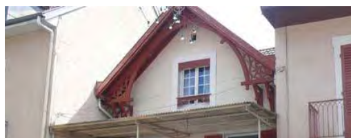
Passées de toit sur contrefiches
