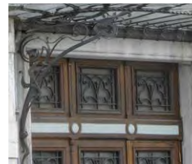
Imposte vitrée en fonte
