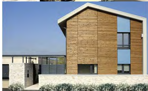
Saint Priest hauts de Feuilly habitat groupé Bois, pierre, métal.
