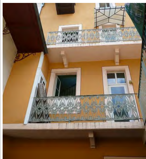
La finesse et la « transparence » des garde-corps contribuent à la qualité de cette façade.
