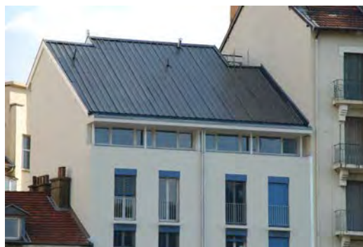
Grenoble. Retrait de l'attique pour créer un balcon et un étage entièrement vitré.
