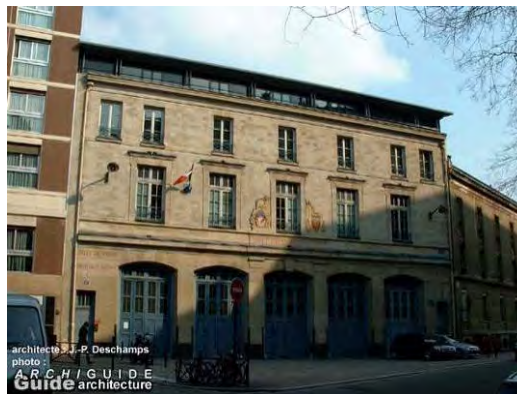
Un cordon formant corniche peut marquer la différence entre la partie ancienne et la nouvelle. Dans ce cas un attique peut être entièrement vitré comme ci-dessus. Surélévation centre de secours Paris 14°
