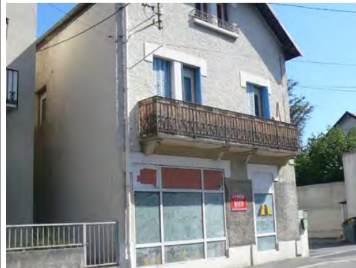
Ici le rez-de-chaussée commercial suit la composition de la façade. Toute future installation devrait respecter ces ouvertures. Av Italie
