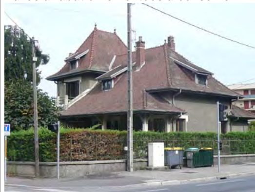
Toiture complexe, couverture en tuiles
