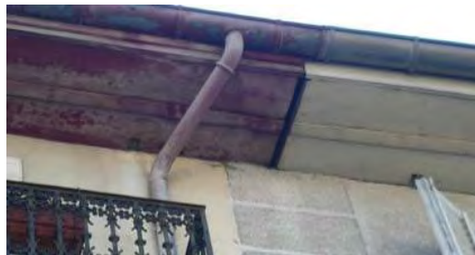
Passées de toit caissonnées traditionnelles
