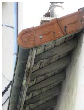
Importance de la passée de toit en rive et en égout
