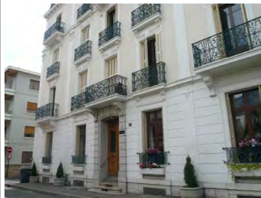
Soubassement et modénature en pierre de taille (ou ciment moulé). rue Garrot
