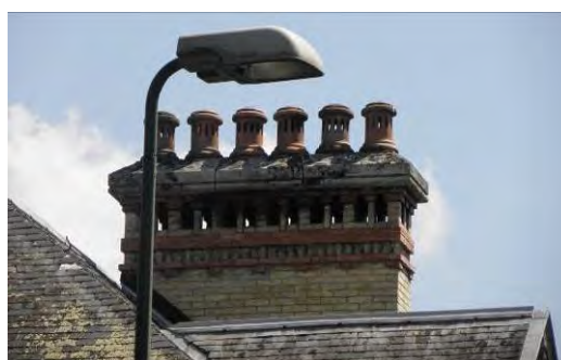
exemple de conduits de cheminée en briques à conserver à l'identique
