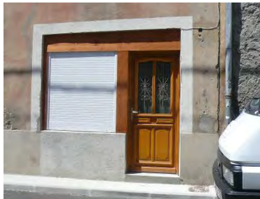
Interdit : bouchement ou agrandissement d'une ancienne ouverture.
