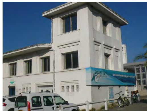
Les enseignes trop grandes portent atteinte à la lecture d'un bâtiment.
