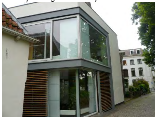
Utrecht (NL), petit bâtiment moderne de plusieurs logements en tissu ancien. Alignement respecté.
