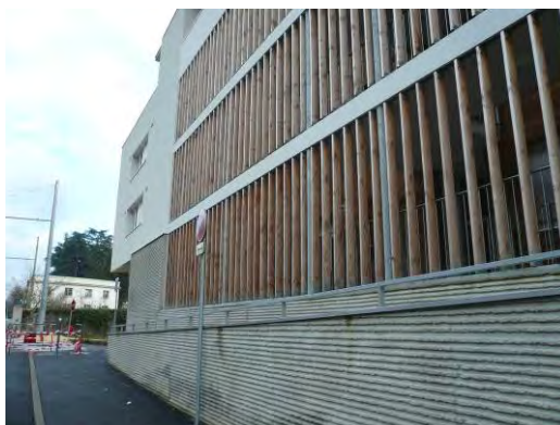
Béton brut structuré, bois ; La Tronche (38)
