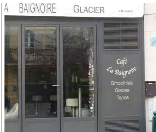
Les climatiseurs peuvent être placés derrière des panneaux ajourés. St Paul Trois Châteaux (26)
