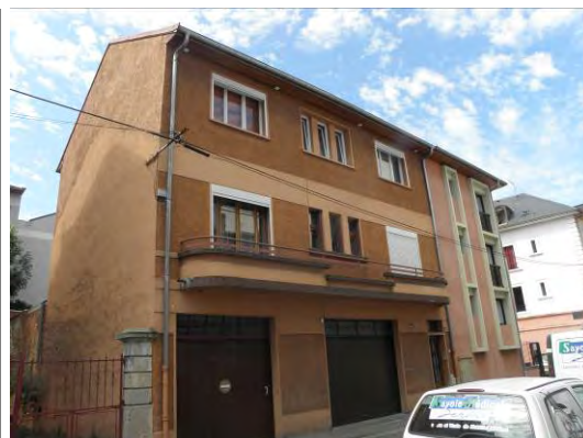
Portes de garages bien placées au rez-de-chaussée d'un petit immeuble du secteur.
