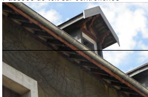
Passée de toit avec chevrons apparents,
