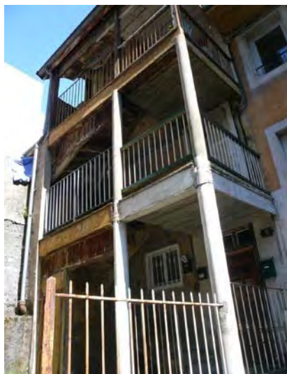
Balcon ancien en bois à conserver
