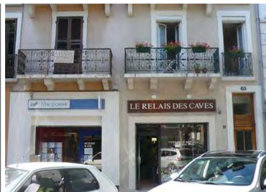
A droite bonne insertion de la vitrine dans l'ouverture existante, à gauche habillage rapporté interdit. Rue du Commerce.
