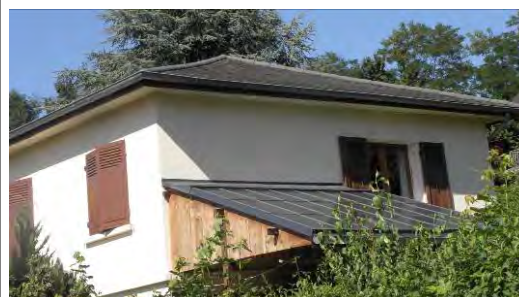
Exemple d'intégration de panneaux solaires en auvent
