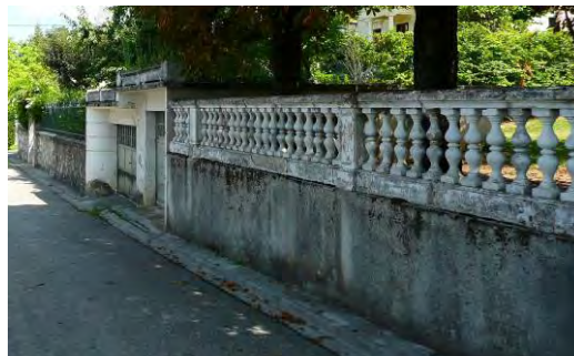
Balustres sur mur bahut, porte de garage
