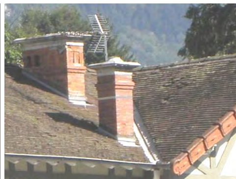
exemple de conduits de cheminée en briques à conserver à l'identique Les antennes peuvent être placées derrière les souches de cheminées
