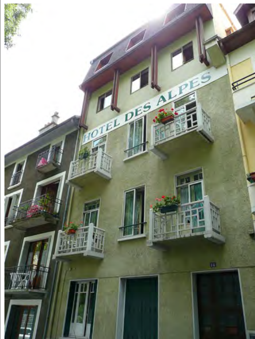
Surélévation sans considération des proportions ni de l'architecture. Eviter. Rue Victor Hugo
