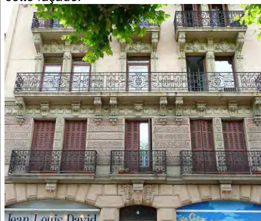
Les balcons contribuent à la hiérarchisation des façades par leur profil et par le garde-corps.
