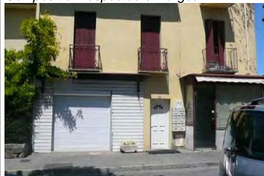
Rez-de-chaussée banalisé, av de Tresserve
