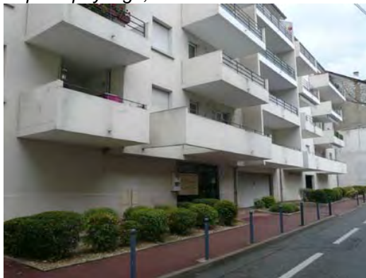
Espace paysagé, rue de la Cité
