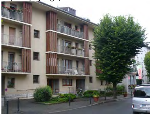
Espace paysagé, Rue de Tresserve
