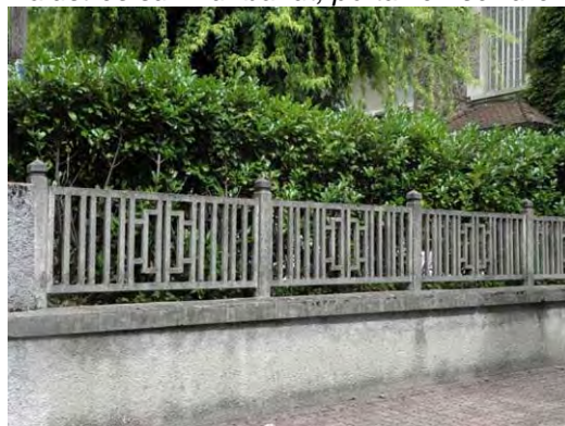
Clôture en ciment moulé, ici sur mur bahut.
