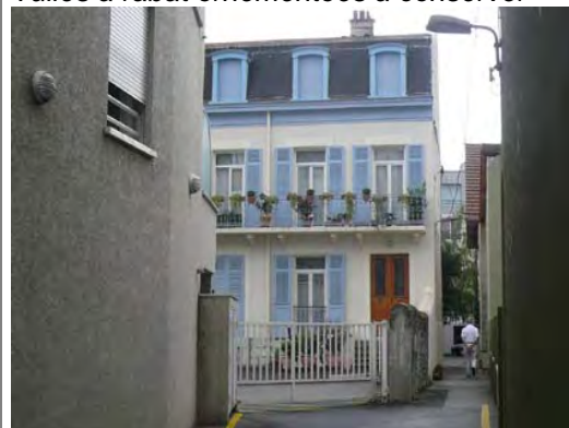
Toit à la Mansart, avenue de Tresserve
