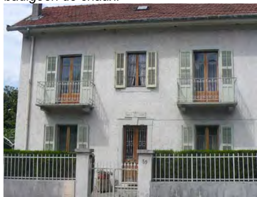
Cas où la limite est aléatoire. L'enduit arrive au nu des pierres de structure. Dans ce cas le bandeau droit doit être dessiné au badigeon de chaux.
