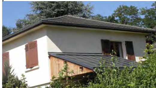
Exemple d'intégration de panneaux solaires en auvent
