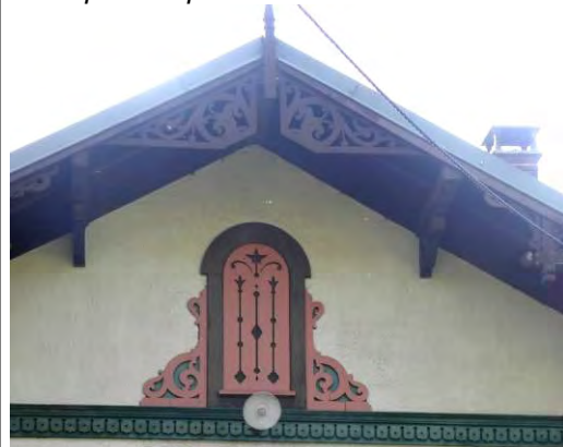
Passées de toit sur contrefiches
