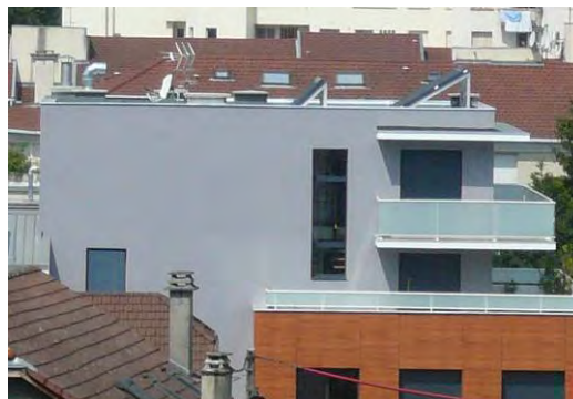
Proscrit : sur les toits terrasse, les installations de plusieurs rangées de panneaux en hauteur (à droite sur la photo). Grenoble
