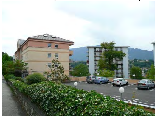
Manque de qualité des espaces de stationnement privés. Bd Roche du Roy
