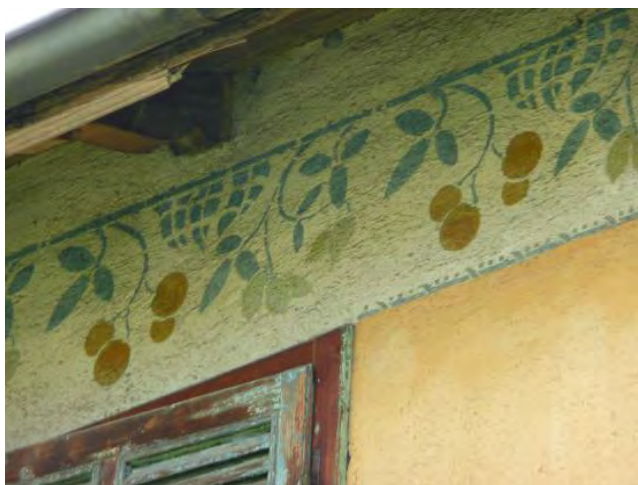
Exemple de décor peint sur enduit lissé à conserver
