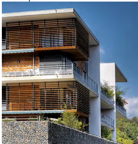
Volumétrie assez ramassée tout en conservant des terrasses.
