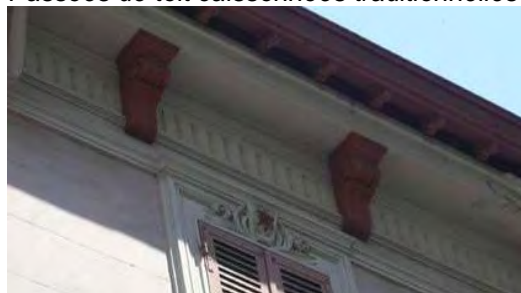
Passées de toit avec corniches moulurées
