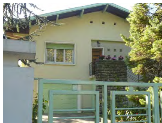
Passée de toit avec chevrons apparents
