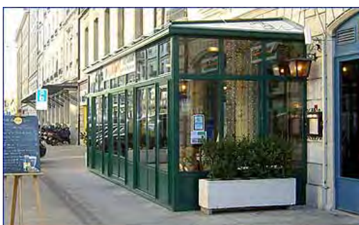
Véranda « parisienne », située à Genève Aménagements extérieurs, mobilier des terrasses: Privilégier les profilés fins et élégants, les matériaux comme le bois et le métal.
