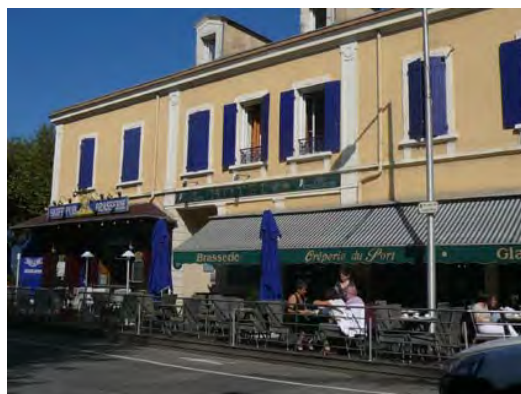
La bâche continue et l'auvent « écrasent » le rez-de-chaussée
