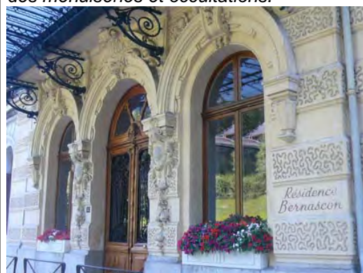
Menuiseries cintrées du Bernascon
