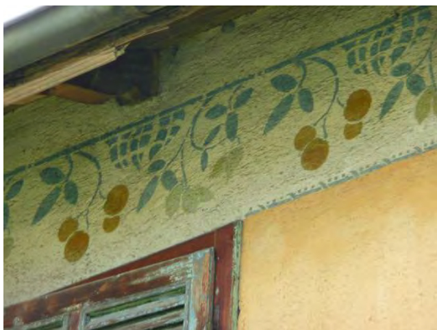
Exemple de décor peint sur enduit lissé à conserver
