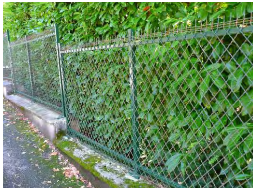
clôture en grillage rigide des années 60
