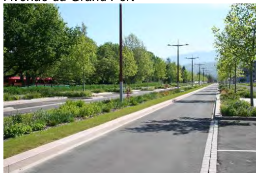
Aménagement qualitatif récent sur une voie d'accès au lac
