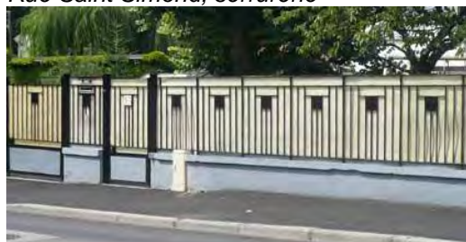
Rue Saint Simond, serrurerie années 60 Le pare vue opaque est regrettable. Eviter.
