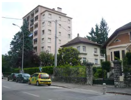
Décalages de hauteur, ce qu'il faudrait éviter....
