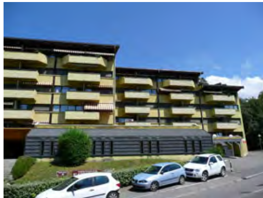
Espace paysagé en pied d'immeuble, bd des Côtes
