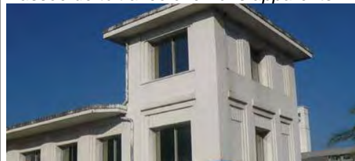
Toitures terrasses de bâtiments de l'architecte Pétriaux (années 30)
