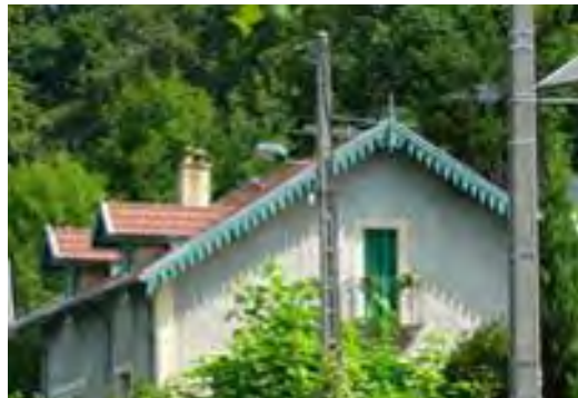
Exemple de lambrequin de toit
