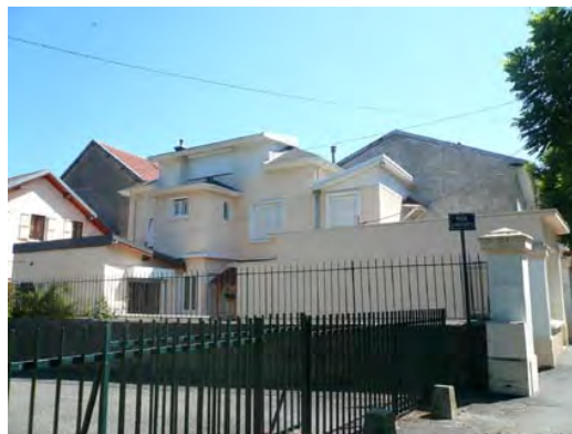
Les différentes interventions sur cette maison ont complètement dénaturé le volume initial.
