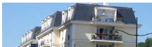
Il faudrait que les lucarnes se fondent plus dans la toiture : si les jouées et les maçonneries étaient de la teinte du toit elles s'intégreraient mieux. La lucarne du mur pignon est disproportionnée
