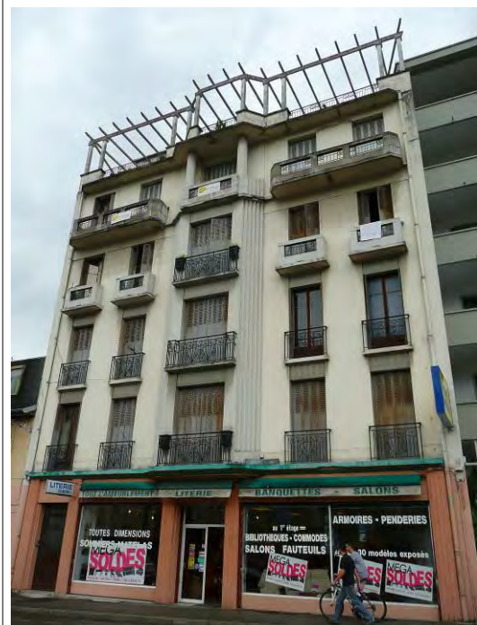
Les balcons contribuent à la hiérarchisation des façades par leur profil et par le garde-corps.
