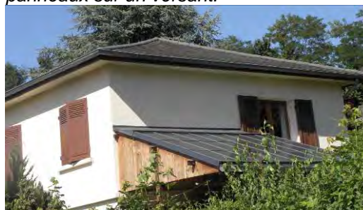
Exemple d'intégration de panneaux solaires en auvent
