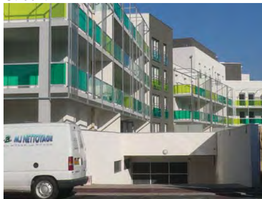
Balcons en verre teinté Entrée des garages à l'arrière de l'immeuble
