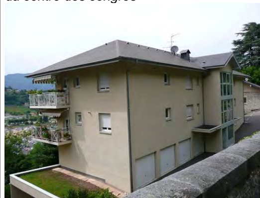
Toiture à pans et toiture terrasse
