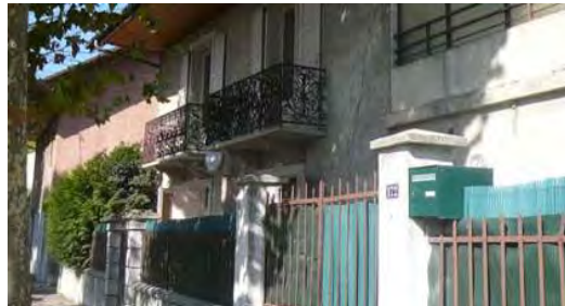
Interdit : pare vue opaque. La position des boites aux lettres est regrettable. Eviter.
