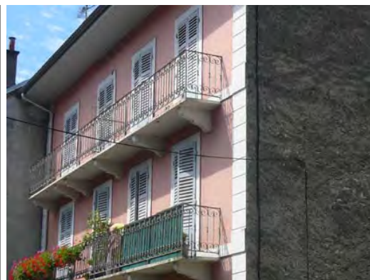
Rue Vaugelas. L'enduit reste en retrait des chaînes d'angle, des encadrements de baies et des bandeaux saillants.
