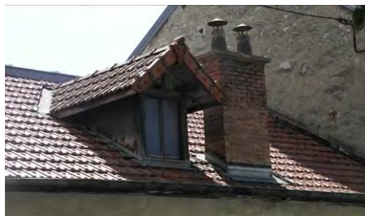
Cheminée et jacobine : les proportions et matériaux sont respectés
