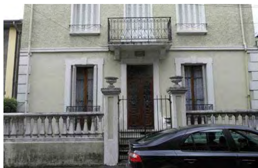
Balustres sur mur bahut, portail en serrurerie
