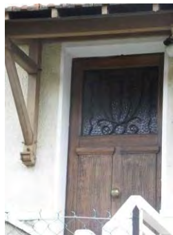
Imposte vitrée en ferronnerie
