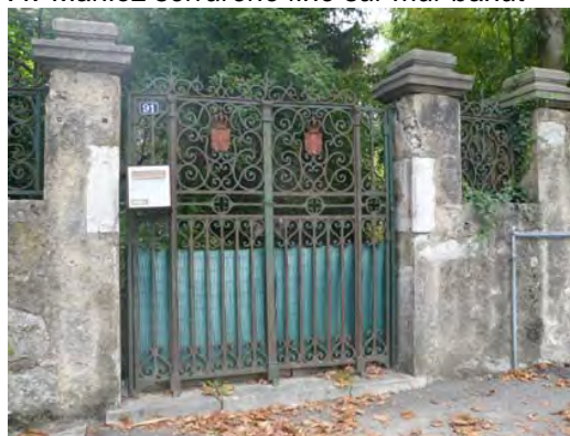
Av Marlioz portail remarquable en serrurerie Le pare vue opaque est regrettable.
