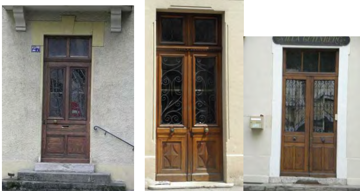
Portes en bois vitrées avec ferronnerie
