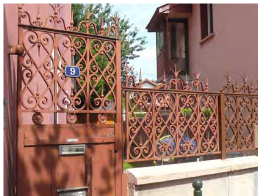
Rue Saint Simond, serrurerie
