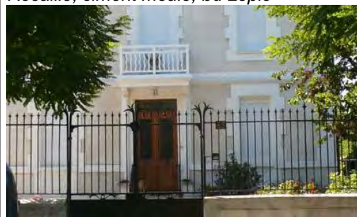
serrurerie fine sur mur bahut av du Petit Port
