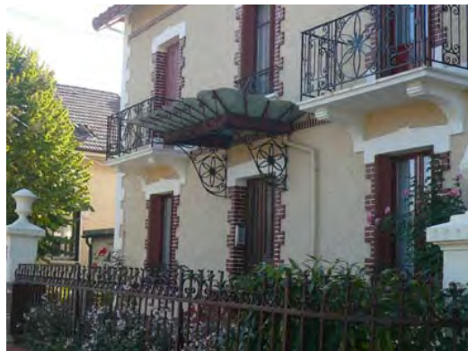
Bd Garibaldi, modénature en relief (pierre ou ciment + briques).
