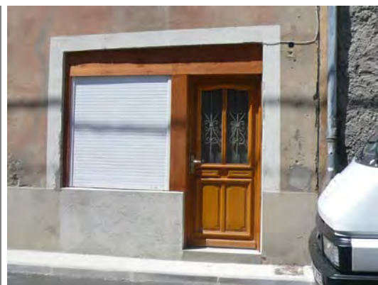
Interdit : le rétrécissement des ouvertures au rez-de-chaussée pour installer des menuiseries standard. Rue du Printemps
