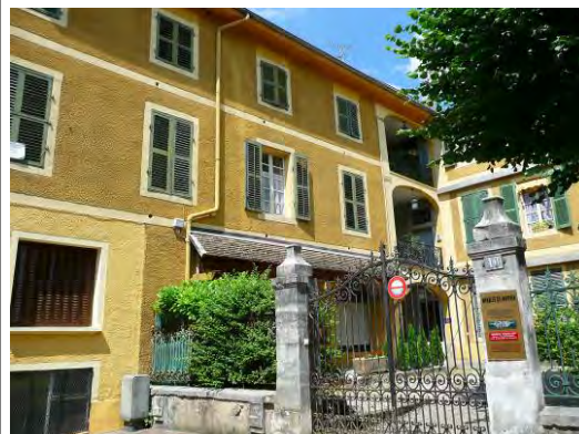
Grille et portail anciens rue du Dauphin
