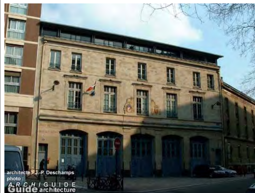
Un cordon formant corniche peut marquer la différence entre la partie ancienne et la nouvelle. Dans ce cas un attique peut être entièrement vitré comme ci-dessus. Surélévation centre de secours Paris 14°
