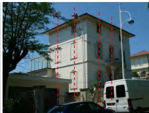
Exemple de façade ordonnancée. Ici des fenêtres obturées des combles pourraient être rouvertes
