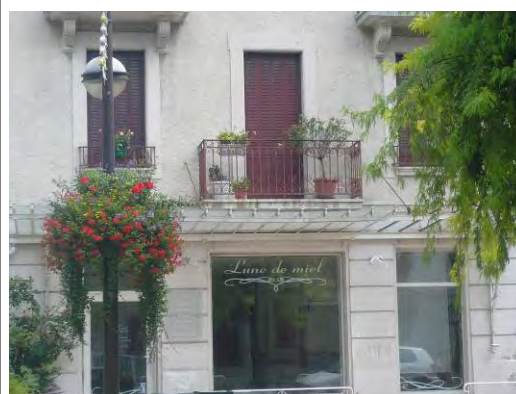
Position correcte des vitrines, marquise. Avenue du Grand Port.
