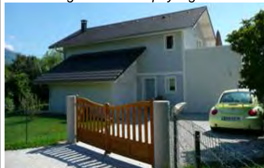
Eviter la banalisation des clôtures et des portails dans ce secteur historique
