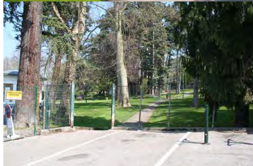
Grille en treillis soudés, grillage dévalorisant les abords et l'entrée du parc thermal
