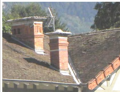
exemple de conduits de cheminée en briques à conserver à l'identique
