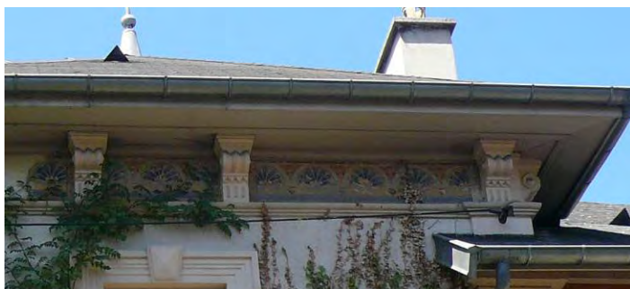
Exemple de décor peint sur enduit lissé à conserver
