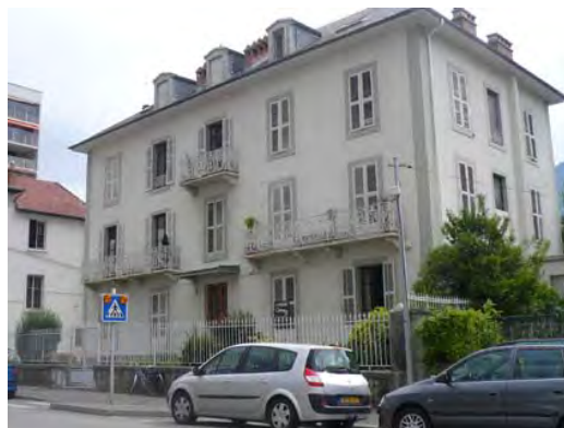
Lucarnes inscrites dans l'axe vertical des ouvertures de la façade qu'elles prolongent. Av Marlioz.
