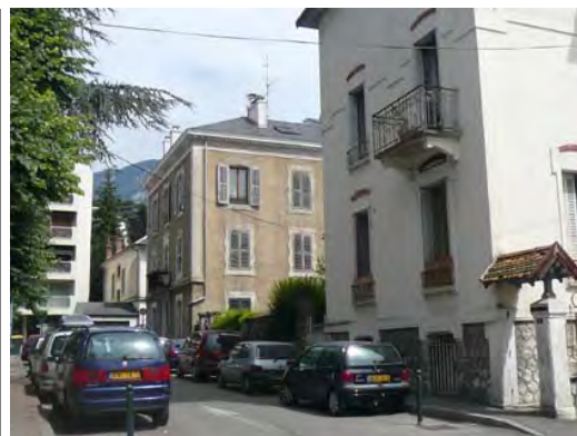
Rue Bonna. L'enduit descend jusqu'au niveau du soubassement
