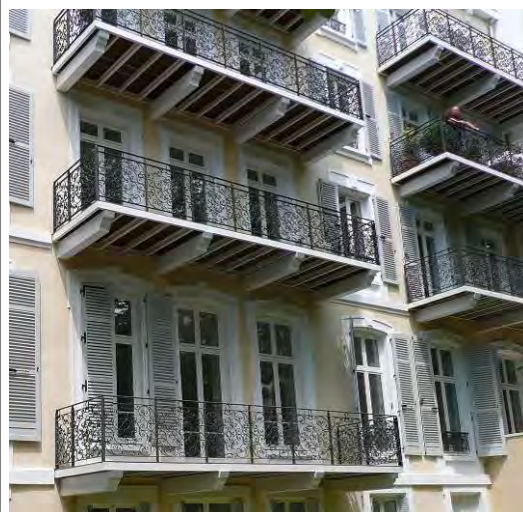
Les balcons neufs de cet ancien hôtel reprennent les principes anciens sur cette façade qui n'en avait pas
