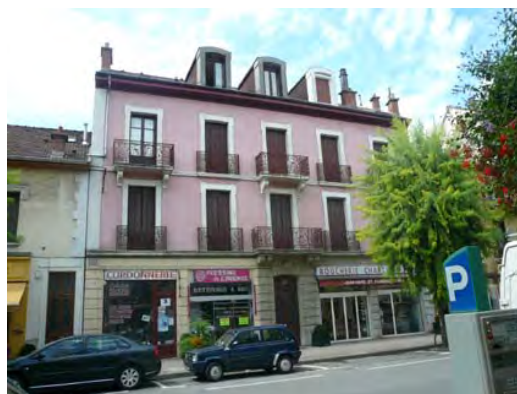
Av du Grand Port. Unité des ouvertures à l'étage
