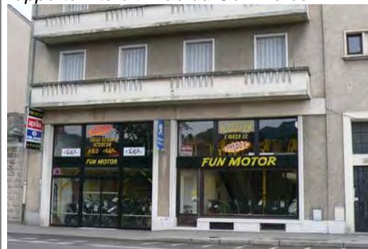
Vitrine bien insérée dans des baies existantes. Bd de Russie.
