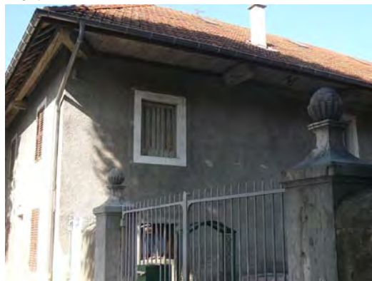
Portail en serrurerie, piliers de portail ornés avenue du Grand Port
