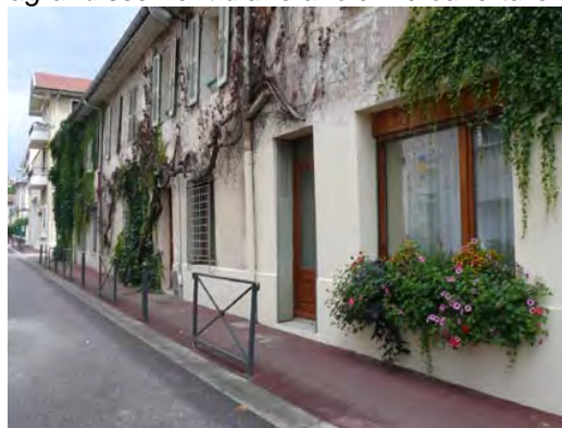
Acceptable : une allège-jardinière a été créée Rue de Liège
