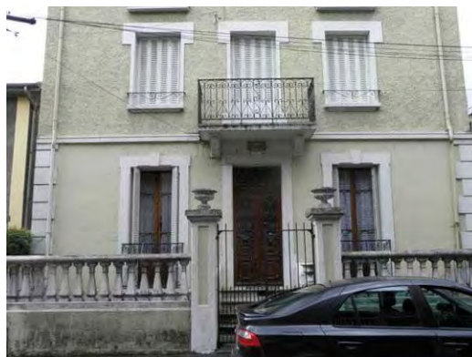
L'enduit recouvre les pierres non appareillées
