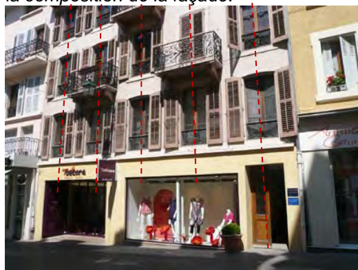
Négation de la composition de la façade : traitement uniforme et continu sur l'ensemble du rez-de-chaussée qui marque l'horizontalité, percements sans lien avec les axes verticaux des étages supérieurs
