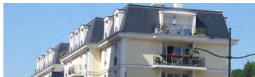
Il faudrait que les lucarnes se fondent plus dans la toiture : si les jouées et les maçonneries étaient de la teinte du toit elles se fondraient mieux.
