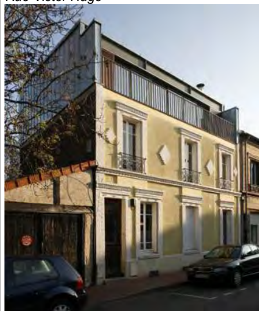
Surélévation immeuble Suresnes (92). Photo arch H. Abadie
