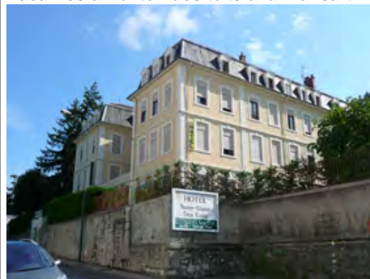
La lucarne prolonge en toiture l'alignement vertical des baies de la façade
