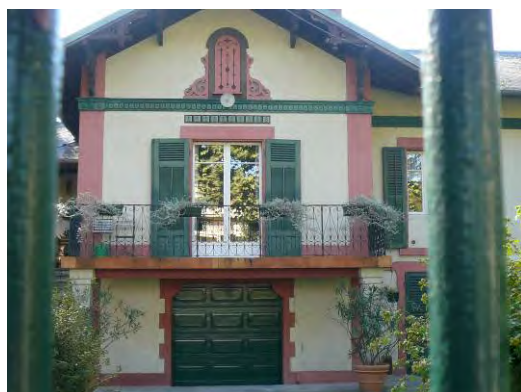
Exemple de décor peint sur enduit lissé à conserver, avenue du Petit Port.
