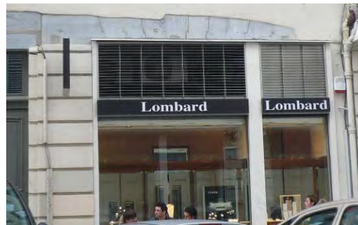
Les climatiseurs peuvent être placés derrière des panneaux ajourés. Grenoble
