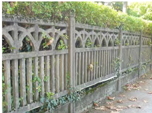
Clôture en ciment moulé, avenue du Petit Port
