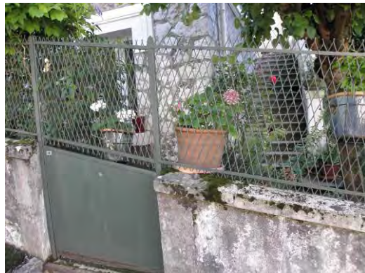
Portail et clôture en grillage rigide des années 60
