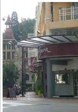
Rue de Chambéry, marquise récente
