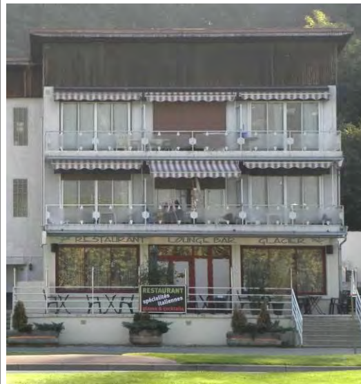
Ici le rez-de-chaussée commercial suit la composition de la façade. L'enseigne sur le balcon est mal positionnée. Av Charcot
