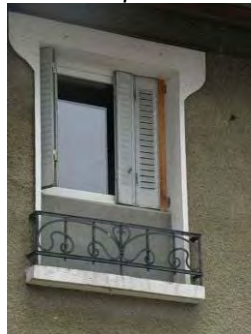
Non. L'ouverture a été rétrécie pour poser une menuiserie standard
