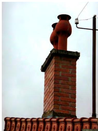
exemple de conduits de cheminée en briques à conserver à l'identique
