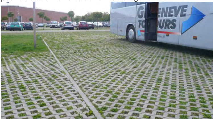
Parking Vitra, Weil am Rhein (Allemagne), revêtement drainant pour les stationnements de cars de tourisme
