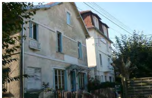
Toit 2 pans, toit à la Mansart, avenue du Petit Port
