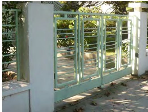
Portail et clôture en serrurerie fine des années 60 av du Petit Port
